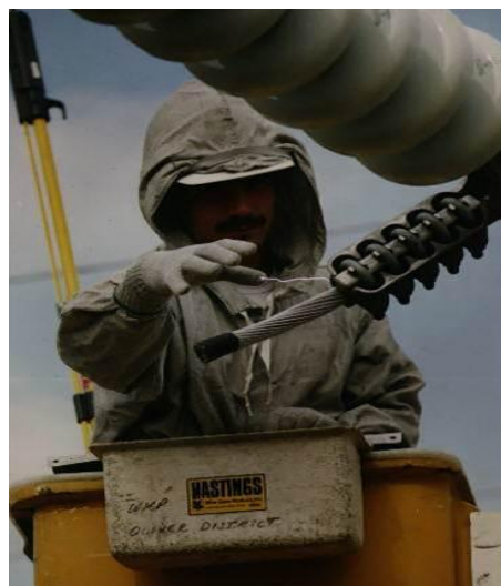
Figur 7, till vänster och figur 8, till höger visar isolerhandskmetoden respektive barhandsmetoden (Lundqvist, Vattenfall).
