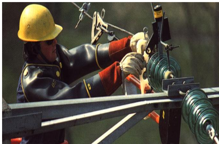
Figur 7, till vänster och figur 8, till höger visar isolerhandskmetoden respektive barhandsmetoden (Lundqvist, Vattenfall).
