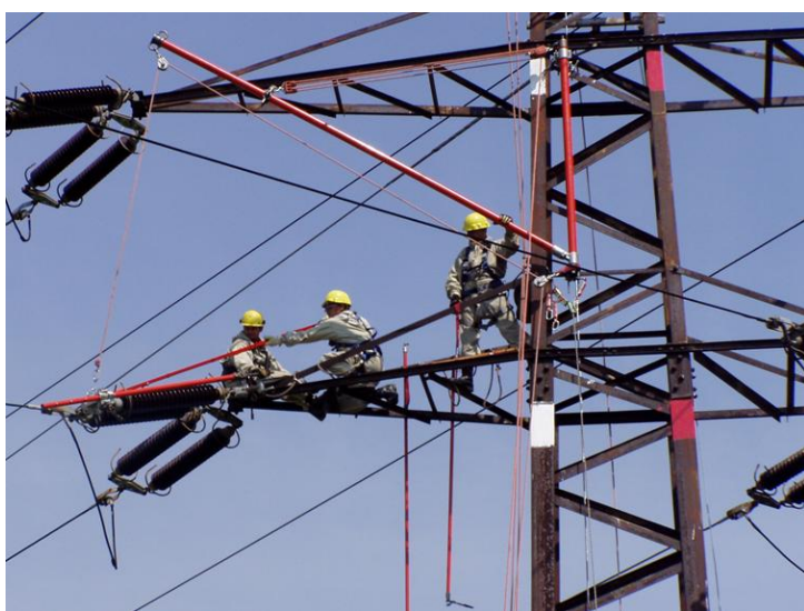
Figur 6: Ett AMS arbete där isolerstångsmetoden används (Lundqvist, Vattenfall).
