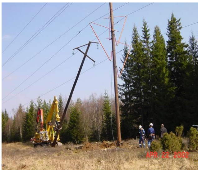
Figur 25: Foto från ett annat stolpbyte som Vattenfall utförde 2002 (Lundqvist, 2002)
