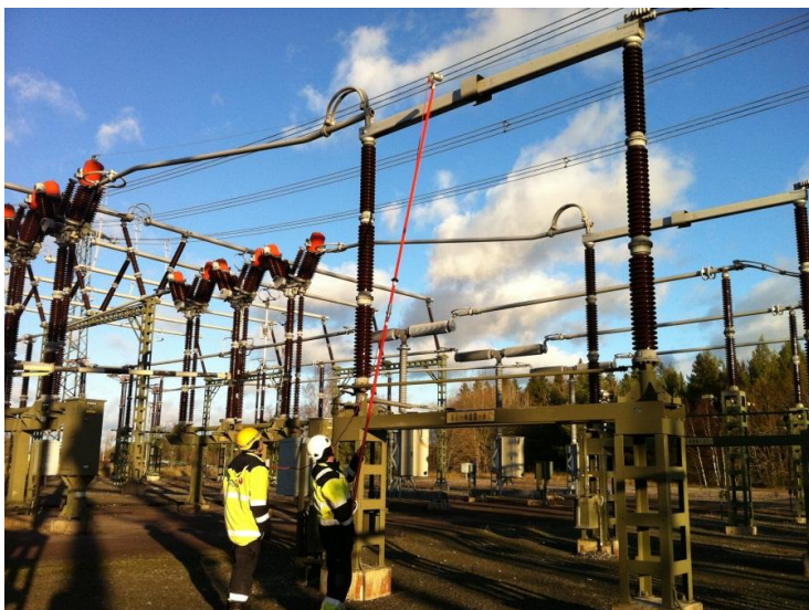
Figur 26 och 27: Till vänster montering av temperatursensor med isolerstångsmetoden, till höger temperatursensor och specialtillverkat verktyg (Egen bild, 2011)
